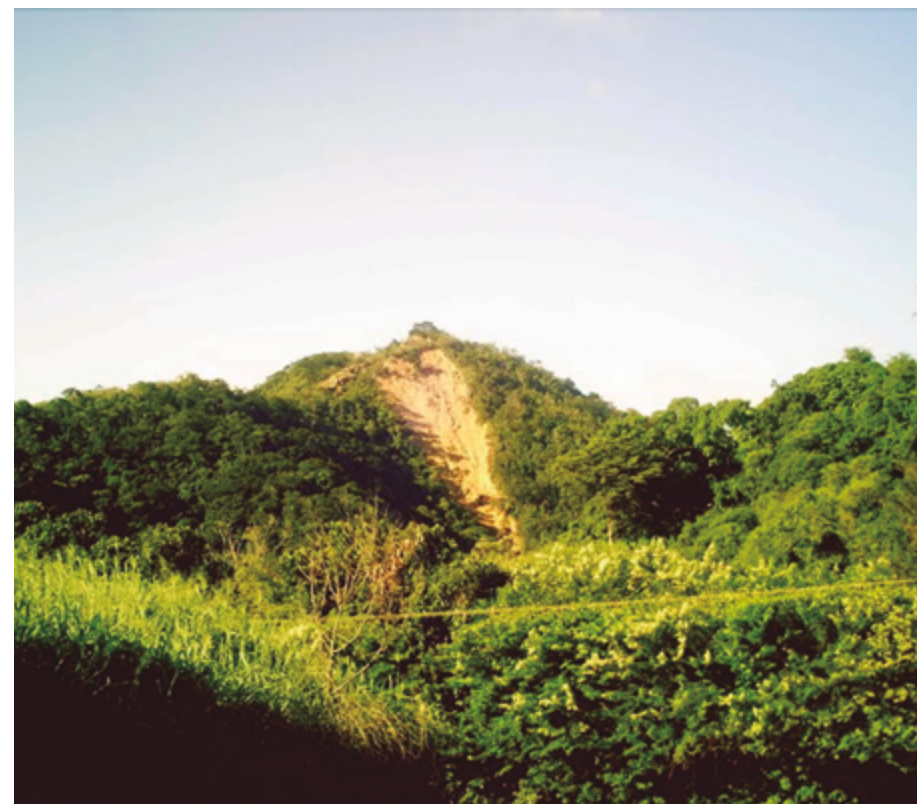
Figura 10: Deslizamento planar deflagrado por causas naturais ocorrido no Morro da Bandeira (bairro Morro do Castro), cuja vegetação encontra-se bem preservada. Fonte: Cátia Tavares.
