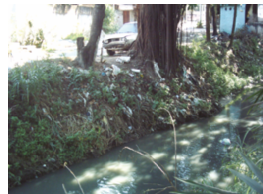
Figura 5 – Av. Imboáçu e arredores: lixo nas margens. Fonte: Thais Alves Gallo Andrade.
